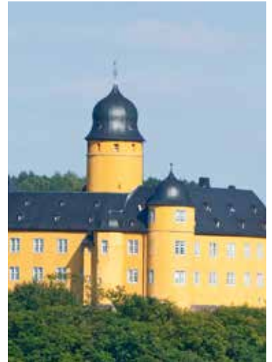
Ansicht des Hauptturmes (Bergfried)
